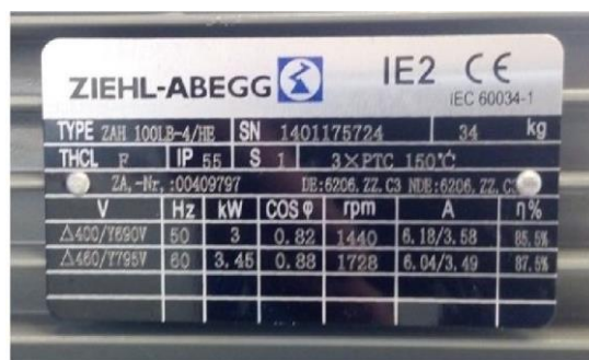
Typenschild des Motors
