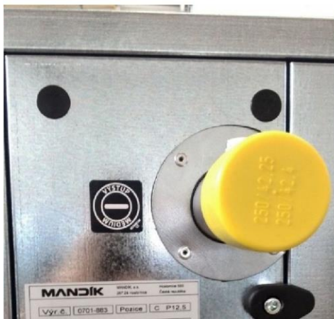
Kennzeichnung des Eingangs in den Wärmetauscher
