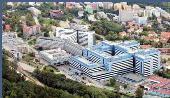
Fakultní nemocnice Motol, Praha Objekt H
